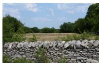
© Atelier construction muret BEAUVALLON St-Anéol le Château
